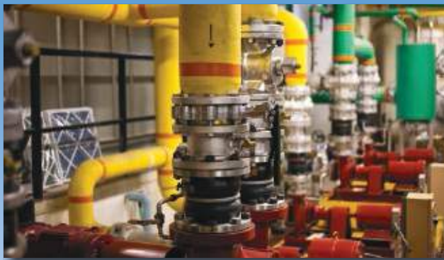
Juntas de Expansión de hule con brida de acero al carbón. En esfera sencilla y doble esfera.
