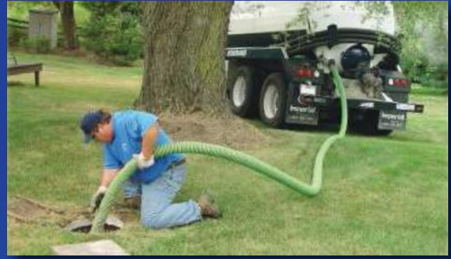
Mangueras de EPDM para limpieza de fosas sépticas. La original Tiger Green (verde) y las nuevas series Tiger Yellow (amarilla), Tiger Blue (azul) y Tiger Red (rojo).
